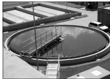
Esgotamento sanitário Canyon.
