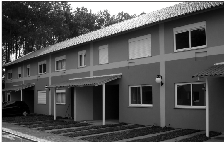
Condomínio Residencial São João.
